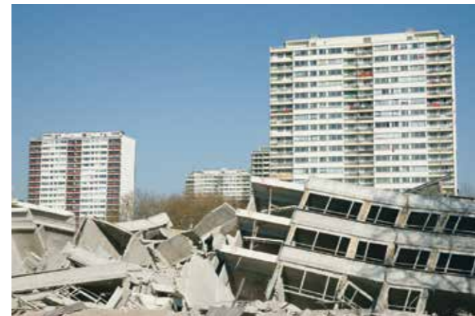
Die Stadt Duisburg ließ ein Hochhaus mit 320 Wohnungen in der Friedrich-Ebert-Straße 10-16 sprengen; ein benachbartes Hochhaus an der Ottostraße 24-30 soll bald folgen. Foto: Werner Schleser, 2019
