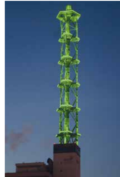
Der „Stadtwerketurm“ in Duisburg-Hochfeld wird nun mittels LED-Technik beleuchtet. Foto: Werner Schleser, 2019
