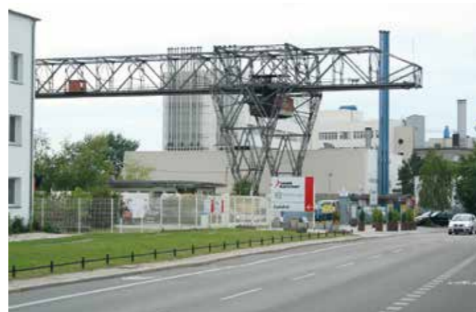
Ein typisches Demag-Produkt ist dieser 1935 für den Umschlag der Vereinigten Berliner Kohlehändler (Vaubeka) erbaute, 122 Meter lange Portalkran zwischen Teillestraße und Teltowkanal in Berlin-Tempelhof. Foto: Sven Bardua, 2013
